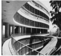
2. Edificio Pedregulho. Río de Janeiro. Affonso Eduardo Reidy. 1947
